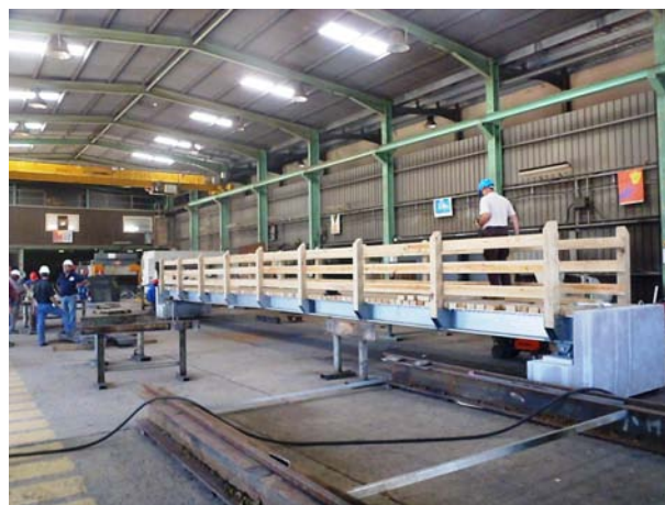
La passerelle pré-montée sur ses appuis en béton armé, en atelier (Gémoce Sarl, déc. 2011)
