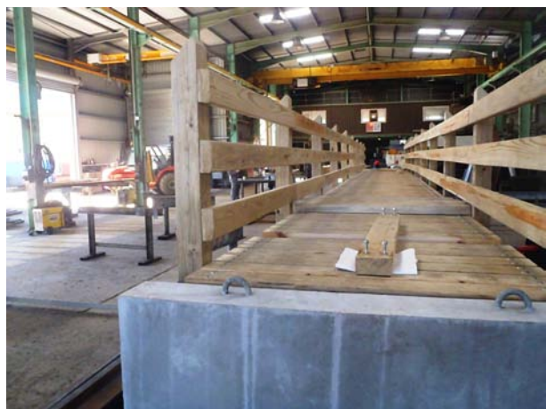
La structure est en acier galvanisée, les platelages et lisses sont en pin traité de N-C (Gémoce Sarl, déc. 2011)
